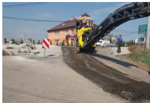
Przebudowa drogi w Goszycach
