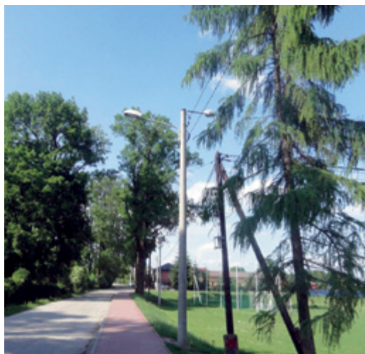
Czulice – ze stacji transformatorowej nr 2544 zamontowano 2 oprawy oświetleniowe wraz z przewodem izolowanym 52mb.
