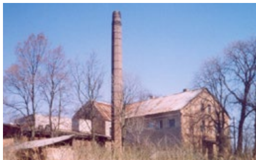
Budynek gorzelnii w Skrzyszowicach w 2003 roku
